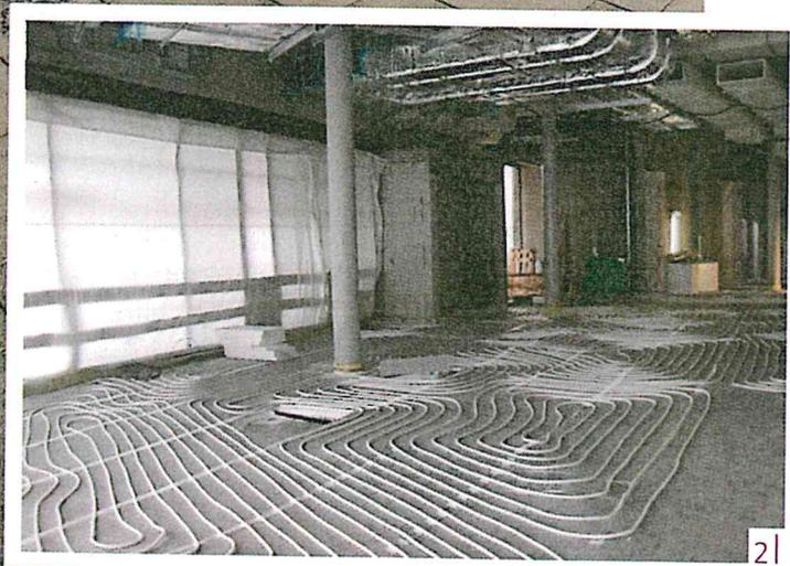
1 | Das Europäische Hansemuseum in Lübeck wird mittels Sole/Wasser-Wärmepumpen mit Heiz- und Kühlenergie versorgt. Das Ensemble im Norden der Lübecker Altstadtinsel umfasst das sanierte Burgkloster und einen Neubau, der in den vorgelagerten Burghügel integriert wurde. Im Neubau kommt ein Fußbodenheiz- und -kühlssystem zum Einsatz.
